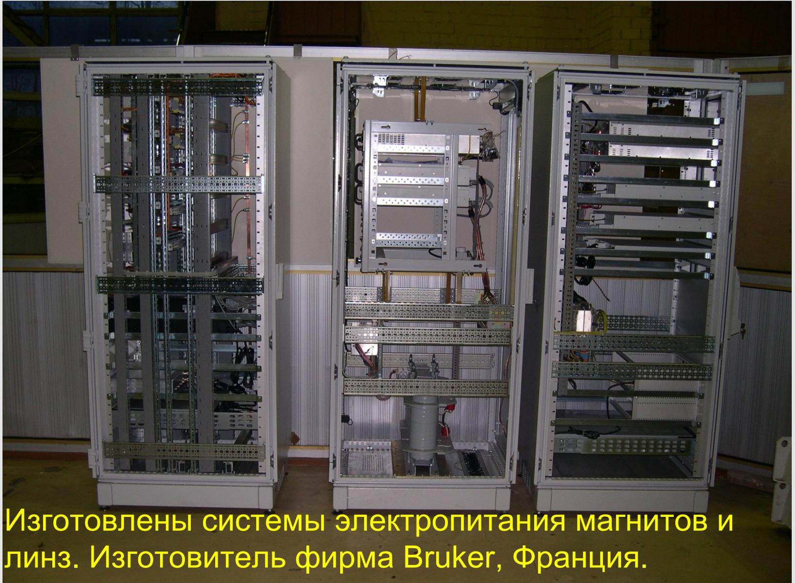
Изготовлены системы электропитания магнитов и линз. Изготовитель фирма Bruker, Франция.
