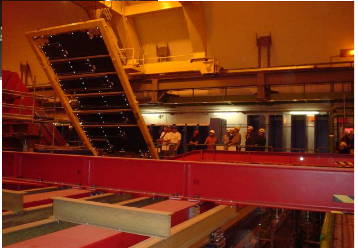
Установка трековой полуплоскости в пещере детектора ALICE
