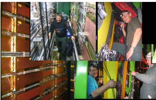
Рис. 19. Монтаж мюонных камер в Мюонной Системе ЛНСб.
