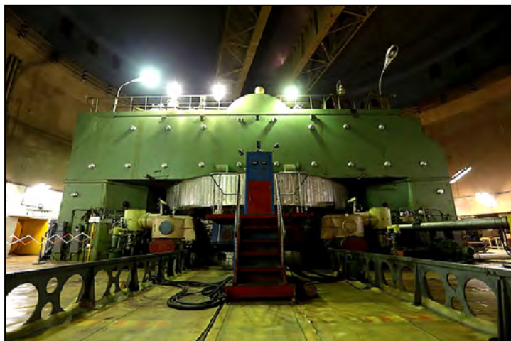
Рис. 1. Внешний вид синхроциклотрона на энергию протонов 1 000 МэВ
