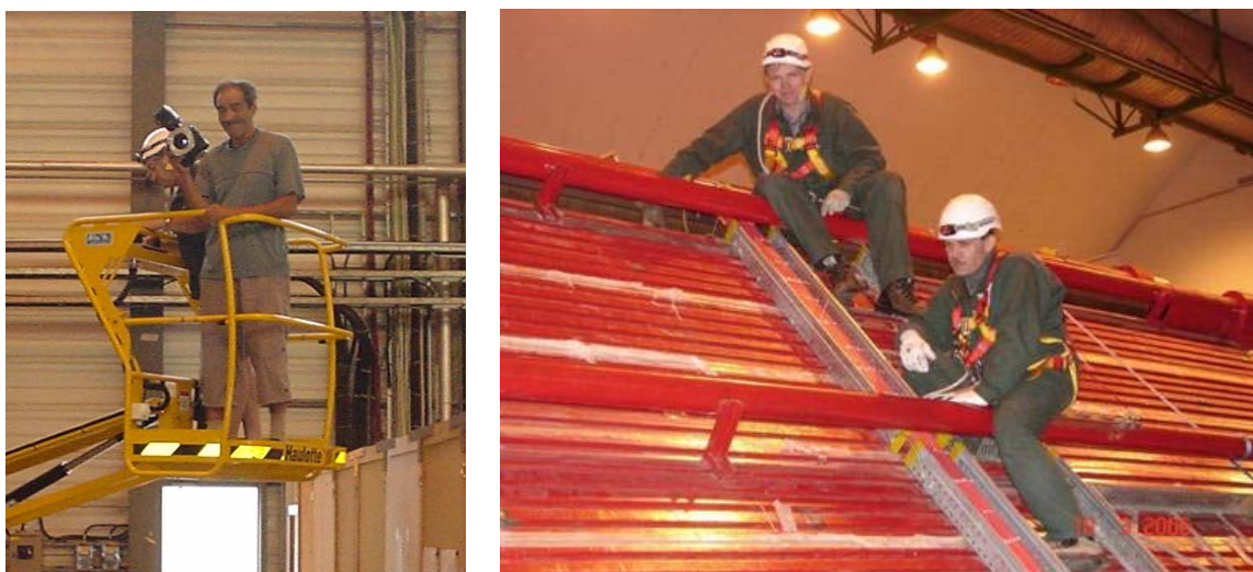
Рис. 10. Геометрическая съемка (слева) и процесс прокладки кабеля (справа) в эксперименте ALICE.
